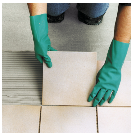
5. ...následně se provede montáž obkladového prvku za pomoci vhodného lepidla PCI.
