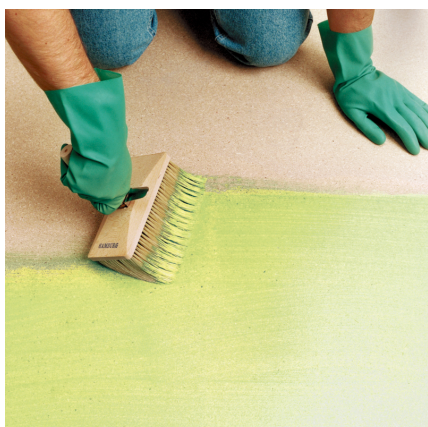
1. PCI Wadian® - první nátěr dřevěného podkladu - celoplošně tzv. do kříže.
