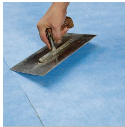
Spoje se přitlačí lžící, pryžovým válečkem nebo latí.
