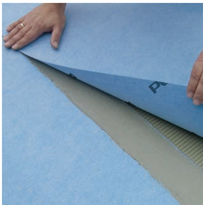
Hydroizolační pás se klade do čerstvé/lepivé vrstvy.
