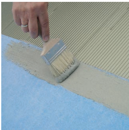
K ideálnímu slepení dvou hydroizolačních pásů PCI Pecilastic® W ve spojih použít PCI Seccoral® 1K/2K Rapid.
