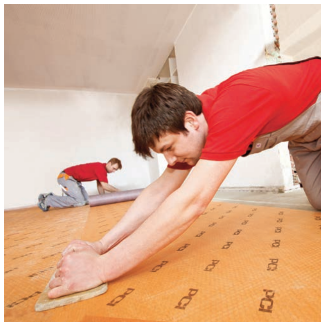
2. PCI Pecilastic® U se při pokládce řádně přitlačí k podkladu pomocí dřevěného prkna, nebo desky z tvrdé gumy.
