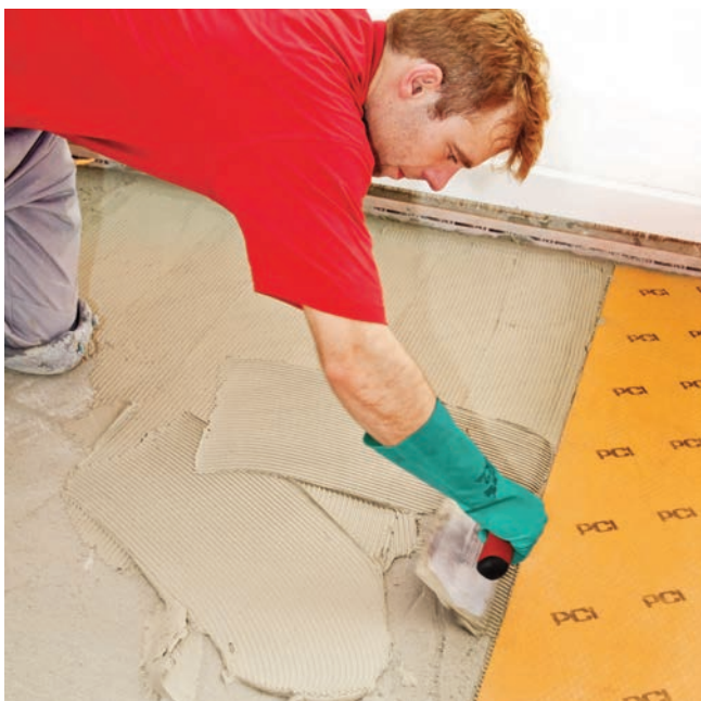
1. Nanášení PCI lepidla pro tekuté lože light na připravený podklad.
