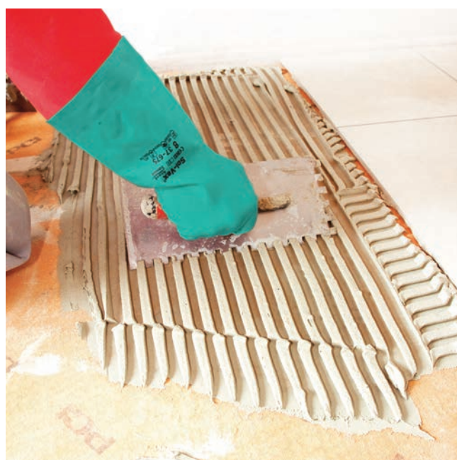
4.....a následně se pokládá keramická dlažba na PCI Nanoflott® light nebo PCI Klebemörtel® S2
