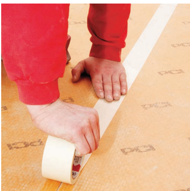
3. V suchých prostorech se jednotlivé spoje slepí lepicí páskou, v prostorech zatížených vlhkostí se izolují pomocí PCI Pecitape® 120, PCI Pecitape® Objekt nebo PCI Pecitape® Butyl...
