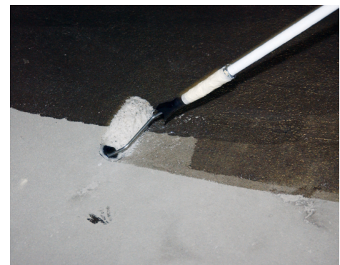
PCI Epoxigrund Rapid se aplikuje na připravený povrch například štětkou nebo válečkem.
